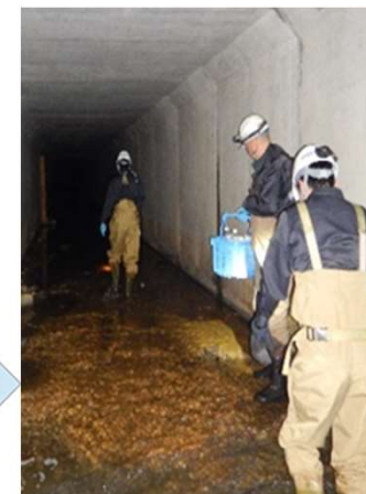
処分場における浸出水等の採取
